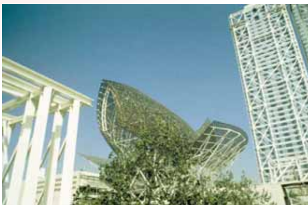
Obr. 5 Kovová konstrukce Ryby, která je smontovaná pomocí sherardovaných šroubů a matic [3]
