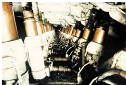
Obr. 7 Podpěrný systém stropů v dolech, jehož některé díly jsou sherardovány [3]
