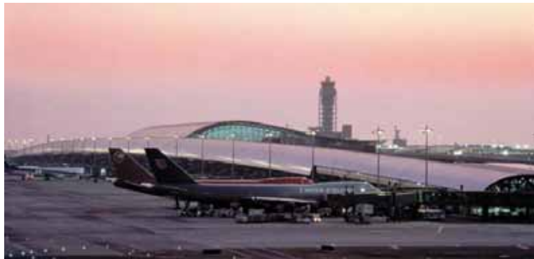
Obr. 6 Terminál letiště, na jehož konstrukci jsou použity sherardované ocelové úhelníky [3]
