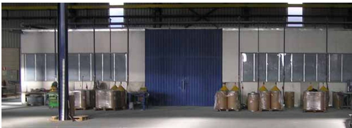
Obr.2: Metalizační komora pro 6 elektrometalizačních zařízení Margarido M45
