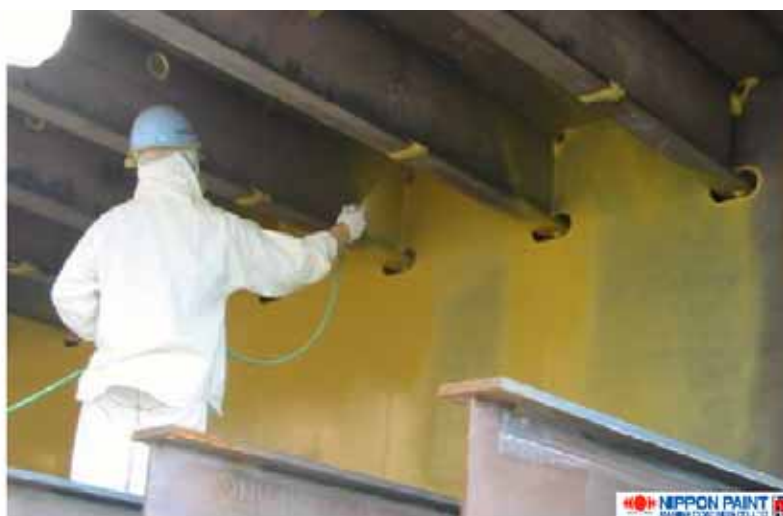
Obrázek: Aplikace základního nátěru NOA 10 F, typ 175. Nátěrový film s místní mokrou tloušťkou pod cca 280 \mu m je zřetelně rozeznatelný díky své transparentnosti či semitransparentnosti.
