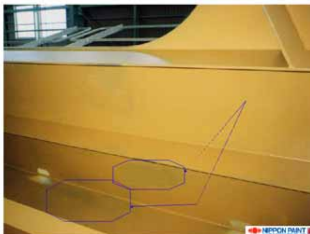
Obrázek: Při kontrole suché tloušťky (DFT) samozákladujícího nátěrového systému NOA 60 HS je snadné vizuálně rozlišit plochy, na nichž nebylo dosaženo požadované DFT 250 \mu m.
