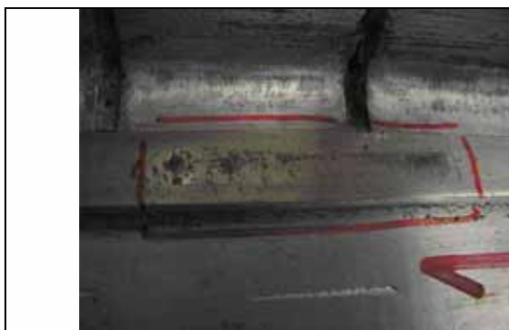
Obr. 4.3 Opotřebení v místě 1
