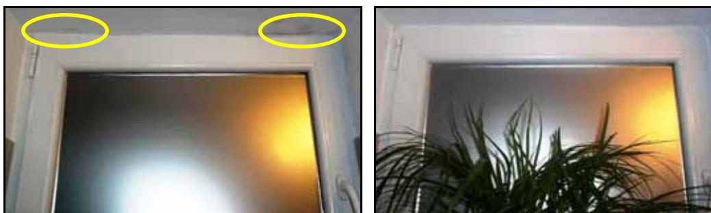
obr.3 - Funkční nátěr FN2 zabrání dalšímu růstu plísní v koupelně (vpravo: 6 měsíců po aplikaci).
