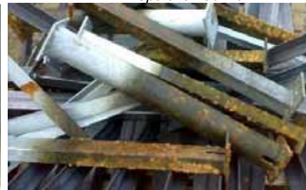
Pozinkované součást po jednom roce expozice v přehradní nádrži
