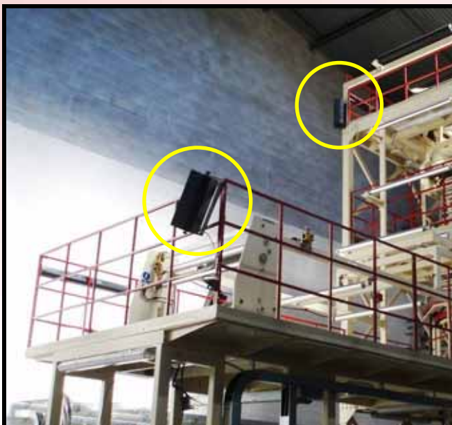
obr.2 - Nátěr čelní stěny v průmyslové hale (k odstranění zápachu při zpracování plastů) fotoaktivním nátěrem FN2; pro zvýšení účinnosti jsou instalovány UVA zářivky s elektrickým příkonem 10W/m 2 (pro běžné účely stačí příkon 10x nižší, resp. dostatečné množství denního světla).
