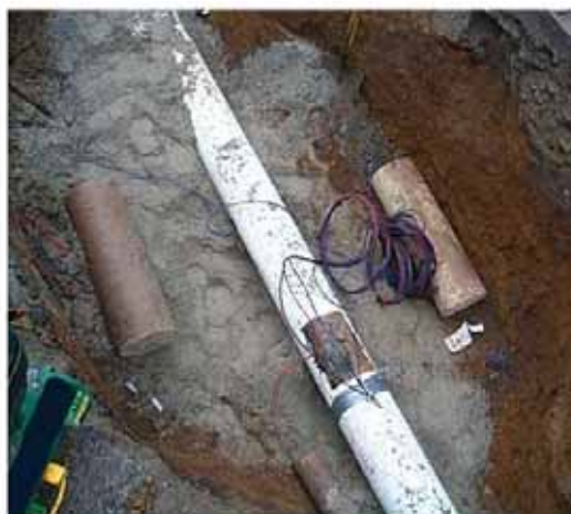
Obr. 4: Katodická ochrana vnějším zdrojem proudu
