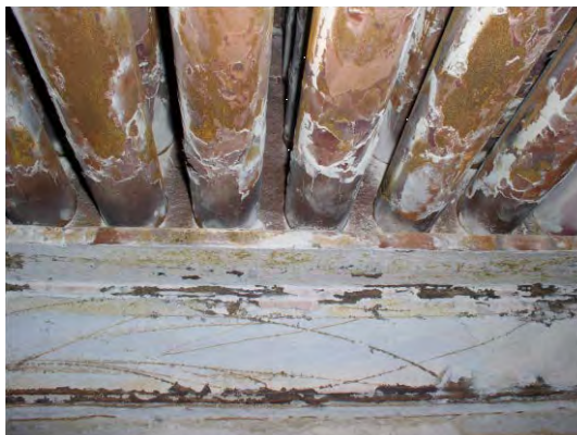
Obr. 3. Poškození trubek výměníku vzduchu LUWO z nelegovaných ocelí bez protikorozi ochrany na elektrárně Kladno
