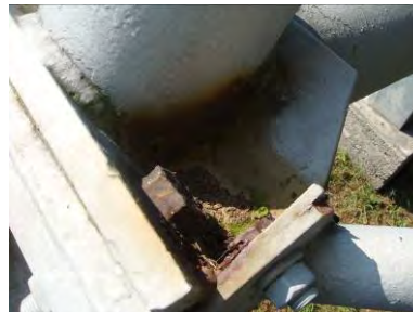
Obrázek 2. vetknutí podélných nosníků
