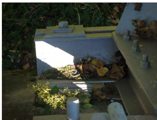
Obrázek 4. Zaneseny koncový příčník
