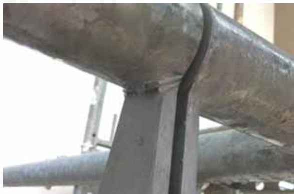
Obr. 1 Kontaktní místo po drátu
