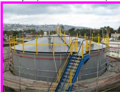
Obrázek 1. Nadzemní zásobník obsahující kapalné palivo s ochranným kombinovaným povlakem.
