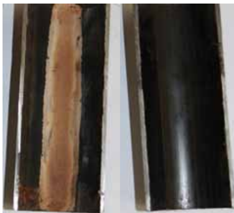
Obr. 2: Provozní výsledky z čištění potrubí od úsad a koroze prostředkem TomCleanEx.
