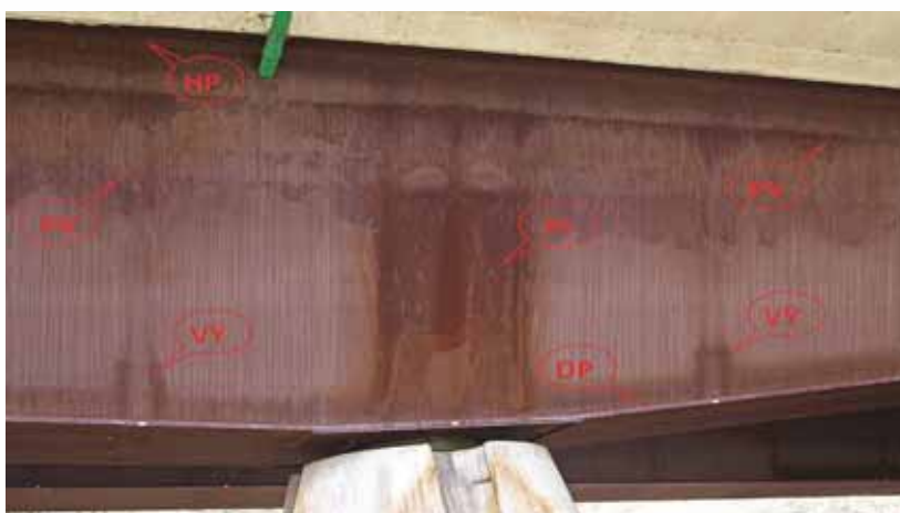
Obr. 7: Část dálničního mostu nad vodním tokem z patinující oceli
