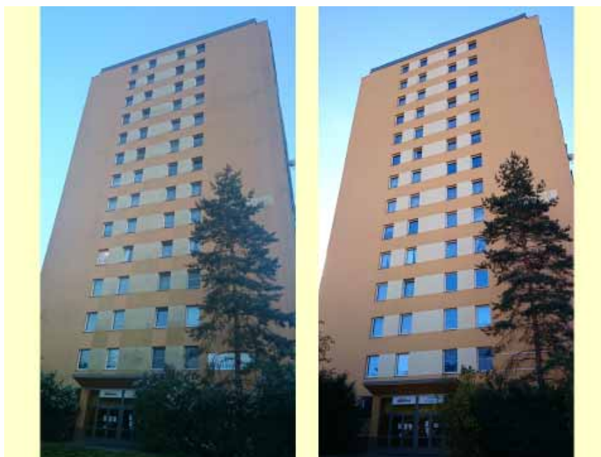
Obr. 3: Ukázka zatepleného panelového domu napadeného řasami před ošetřením systémem BALCLEAN (vlevo) a po něm (vpravo).
