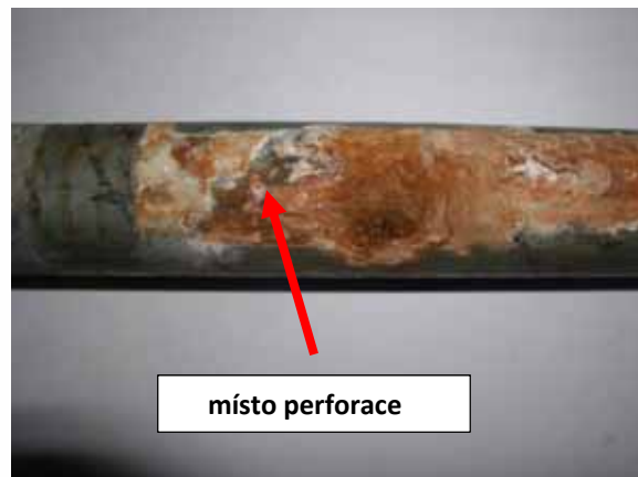
Obr. 9 a 10: Trubky po vyjmutí z izolace
