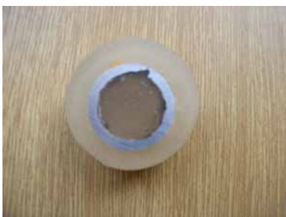
Obr. 17: Řez místem perforace trubky
