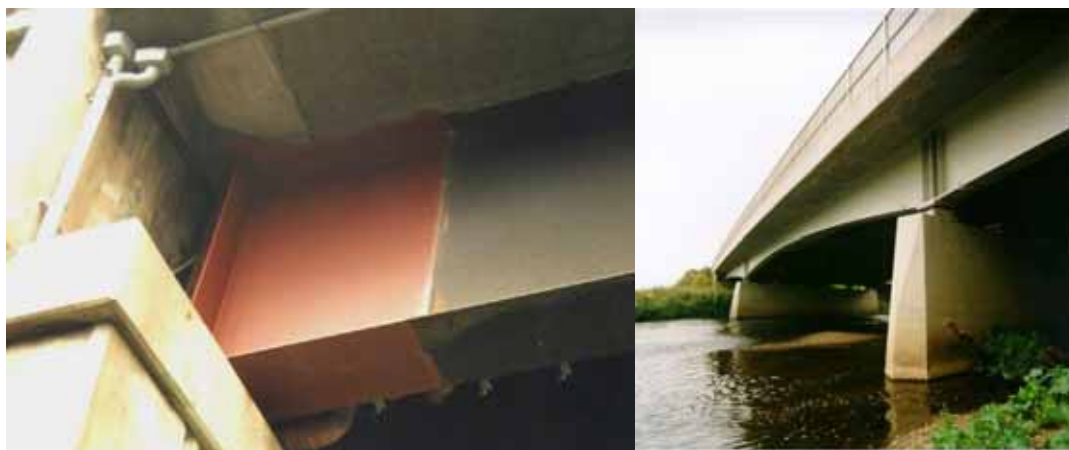
Obř. 4: Lokální povlakování konstrukce z patinující oceli (vlevo), zhotovení kompletní PKO (vpravo)[7]
