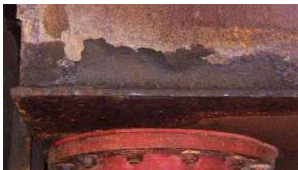
Obr. 9 Svinovský tramvajový most koroze patinující oceli po vrstvách
