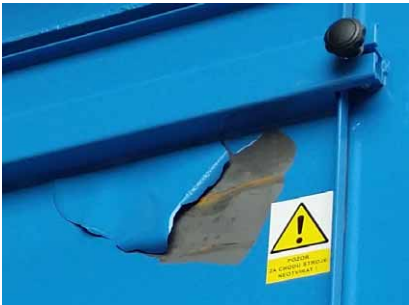
Obr. 1: Neotryskaný, špatně odmaštěný povrch – stav po 2 měsících vystavení na venkovní atmosféře
