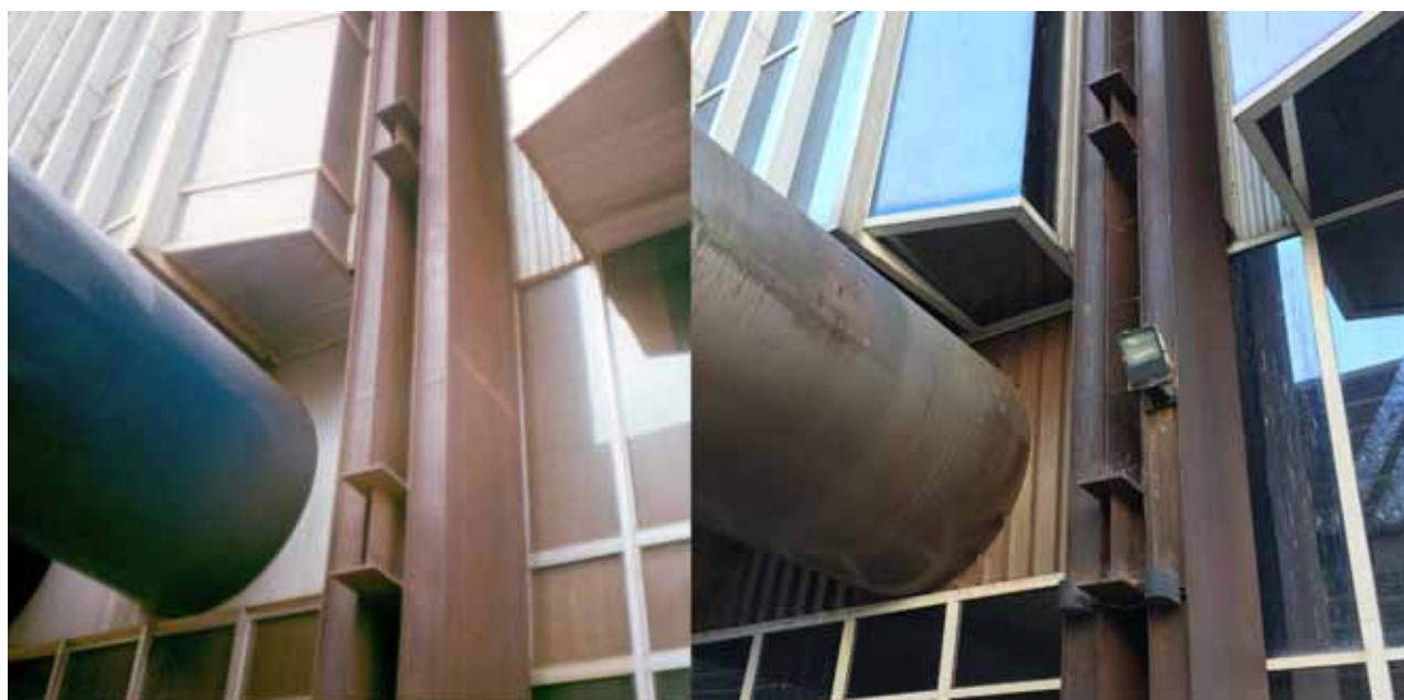
Obr. 2: Detail zakomponování sloupu z materiálu typu Atmofix do budovy Transgasu na Vinohradské třídě – vzhled patiny v roce 1979 (vlevo) [17] a v roce 2018 (vpravo)
