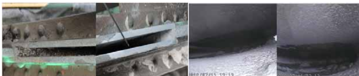
Obr. 8: Zvolené zkušební místo č. 6 – Vlevo: štěrbina před tryskáním pískem, další obrázky: štěrbina po otryskání
