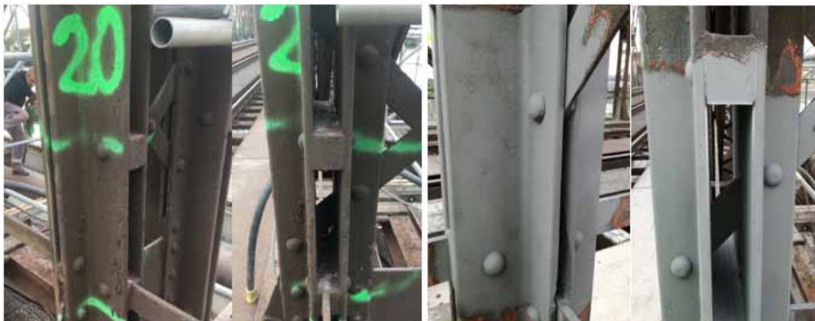
Obr. 9: Zvolené zkušební místo č. 7 – Vlevo: štěrbina před tryskáním pískem, další obrázky: štěrbina po otryskání
