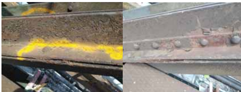
Obr. 1: Vlevo: neprůchozí štěrbina v diagonále s těžkým přístupem, vpravo: štěrbina nad dolním pásem
