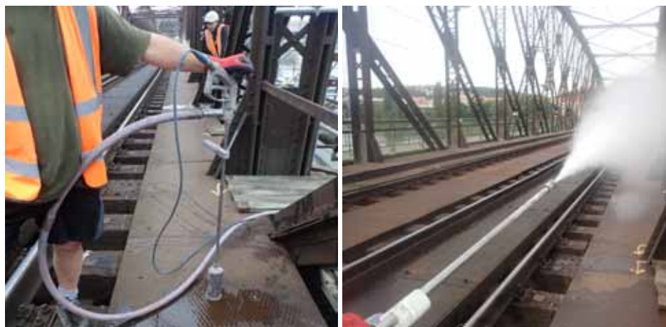
Obr. 4: Vlevo Ukázka rotační trysky pro tryskání vodním paprskem, vpravo: ukázka demoliční trysky s vodním paprskem o síle až 2500 bar
