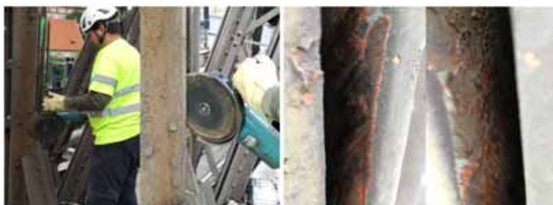
Obr. 9: Mechanická předúprava pomocí řezného kotouče
