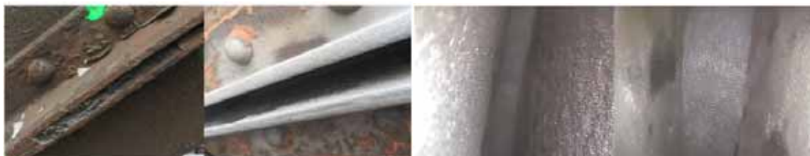
Obr. 8: Zvolené zkušební místo č. 8 – Vlevo: štěrbina před tryskáním ocelovou drtí, další obrázky: štěrbina po otryskání
