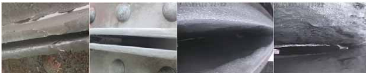
Obr. 7: Zvolené zkušební místo č. 5 – Vlevo: štěrbina před tryskáním pískem, další obrázky: štěrbina po otryskání
