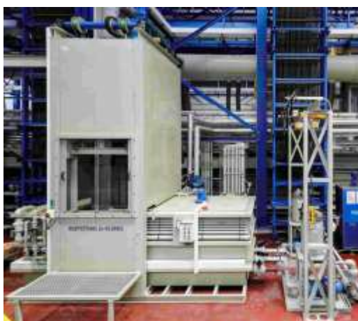
Obr. 12: Rozpouštěcí stanice zinku se zdvihacím mechanismem s mikrozdvihem
