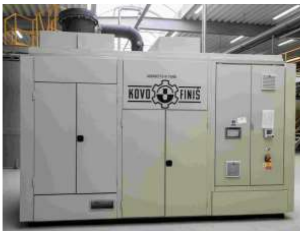
Obr. 14: Vakuová odparka s mechanickou kompresí par
