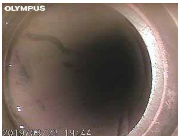
Ukázka vyčištění vnitřních povrchů.
