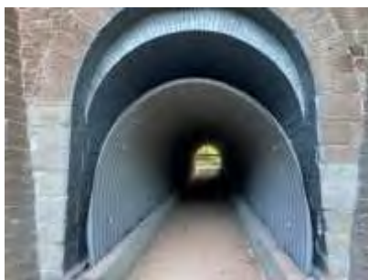
Obr. 4: Systém izolace na bázi polyurey aplikovaný na původní pískovcovou mostní klenbu
