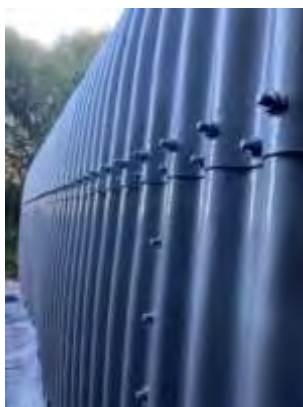
Obr. 3: Systém izolace na bázi polyurey aplikovaný na ocelovou flexibilní konstrukci typu MULTI-PLATE
