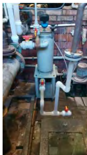
Obr. 9, 10, 11 a 12: Instalace PVDF čerpadla s filtračním aparátem vně nádrže. Filtrace a cirkulace lázně chemického niklování. Linka chemického niklování.
