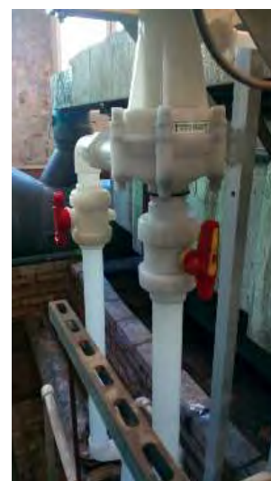
Obr. 9, 10, 11 a 12: Instalace PVDF čerpadla s filtračním aparátem vně nádrže. Filtrace a cirkulace lázně chemického niklování. Linka chemického niklování.
