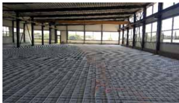
Obr. 1: Příklad technologie s použitím tepelného čerpadla země/voda (konkrétně IVT GEO G pro vytápění i chlazení objektu se sálavým plošným systémem LoWaTec), Zdroj: GT Energy
