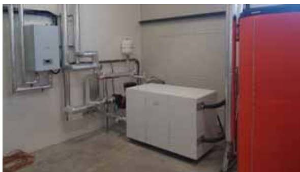
Obr. 1: Příklad technologie s použitím tepelného čerpadla země/voda (konkrétně IVT GEO G pro vytápění i chlazení objektu se sálavým plošným systémem LoWaTec), Zdroj: GT Energy
