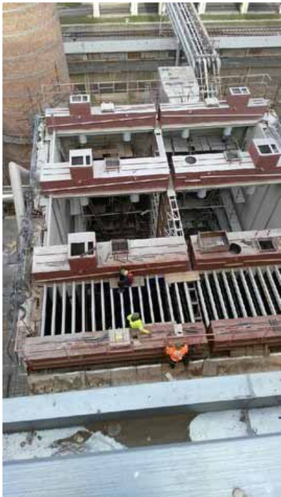
Celkový pohled shora na rekonstruovaný elektrický odlučovač prachových částic elektrárna Hodonín; Vlevo: Elektrický filtr teplárna Mydlovary. Oba filtry opatřeny povlakem Novaguard 4801, realizaci provedla firma ALLGARD CZ
