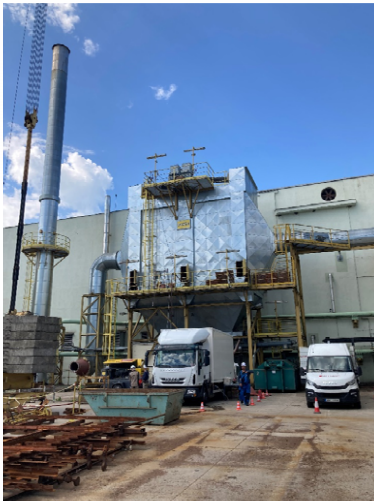
Celkový pohled shora na rekonstruovaný elektrický odlučovač prachových částic elektrárna Hodonín; Vlevo: Elektrický filtr teplárna Mydlovary. Oba filtry opatřeny povlakem Novaguard 4801, realizaci provedla firma ALLGARD CZ
