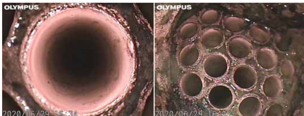
Obr. 6: Ukázka vyčištění vnitřní primární strany teplosměnné plochy výměníku
