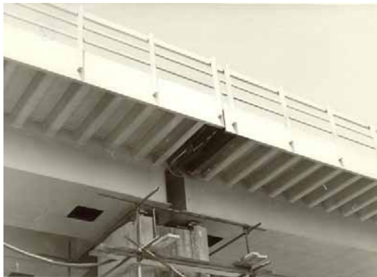
Obr. 8: Severojižní magistrála – spojení mostovek s tepelnou dilatací od vozovky (1978)
