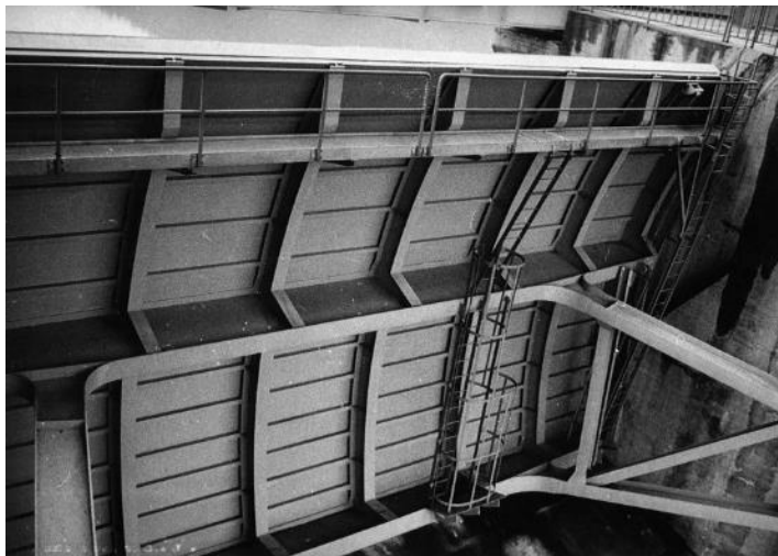
Obr. 4: Korunový uzávěr – přehrada Orlik
