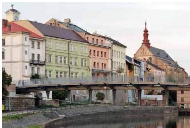
Obr. 2: Obnova Komenského mostu v Jaroměři žárovým zinkováním ponorem, rok 2015
