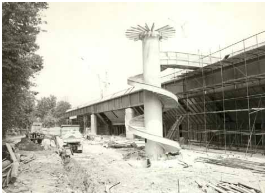
Obr. 9 Odbavovací hala Hlavního nádraží – točité schodiště po provedení žárového nástřiku (1977)
