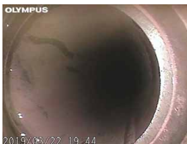
Ukázka vyčištění vnitřních povrchů teplosměnných ploch ...
