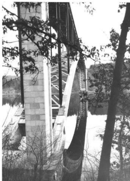
Obr. 5: Žďákovský most – pohled z břehu na obloukovou ocelovou konstrukci (1967)
