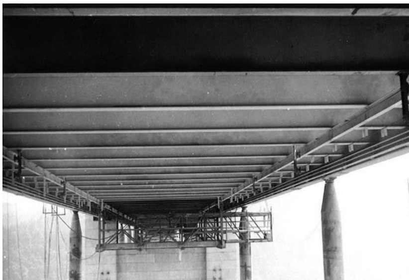
Obr. 6: Žďákovský most – pohled na mostovku ocelové konstrukce (1967)
