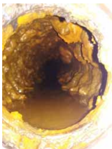
Ukázka vyčištění vnitřních povrchů teplosměnných ploch..
