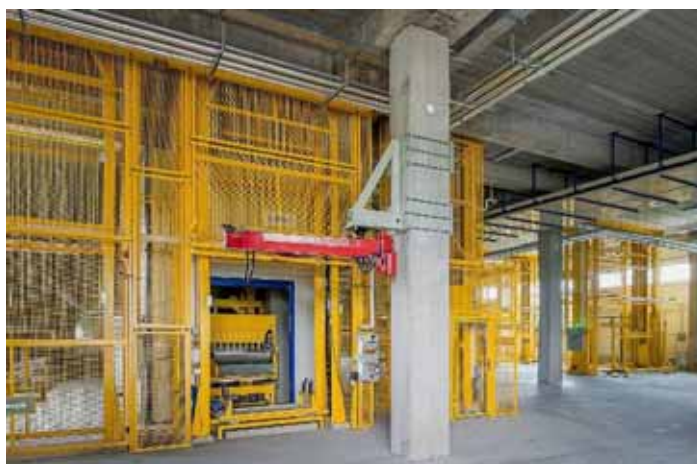
Obr. 2: Vstupní a výstupní úseky v přízemí haly povrchových úprav
